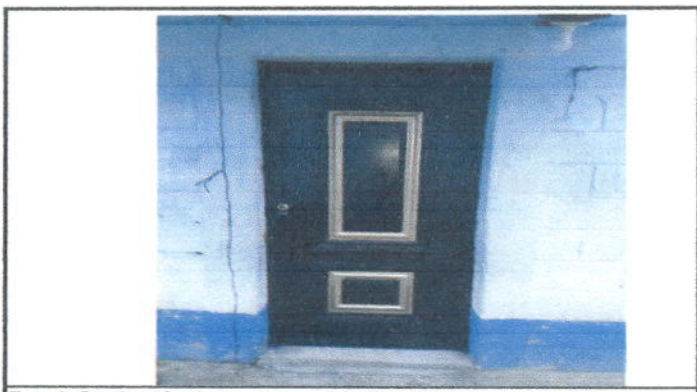
Foto 3: Sustitución de puerta metal de (2.10*0.88) en modulo III
