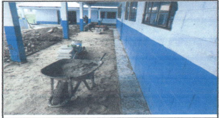
Foto 2: Sustitución de piso por piso granito en módulo I
