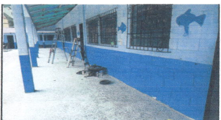
Foto 6: Instalación de balcones de hierro en ventana. Módulo I
